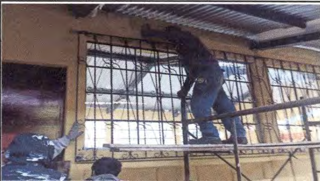
Foto 15: Fabricación e instalacion de balcones para protección del aula
