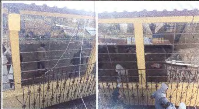
Foto 8: Mantenimiento de balcones (lijar, cepillar, pintar, reparar)
