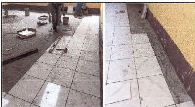
Foto 9: Sustitución de piso de cemento liquido
