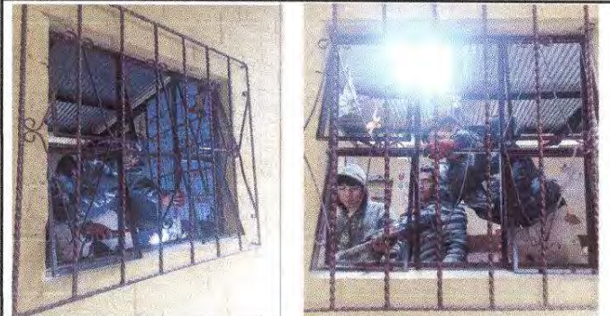
Foto 6: Sustitución de ventanas de madera por ventanas de metal, más vidrio
