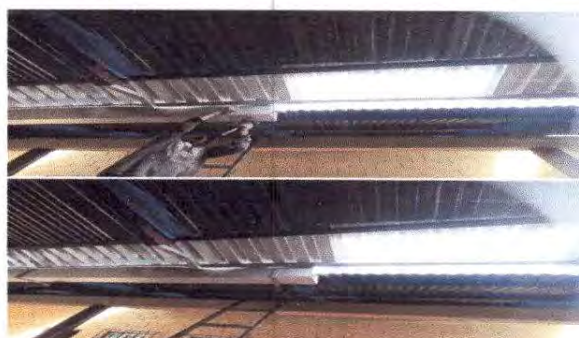
Foto 10: Sustitución de canal de metal por canales de lamina aluzinc calibre 24 con sujetadores
