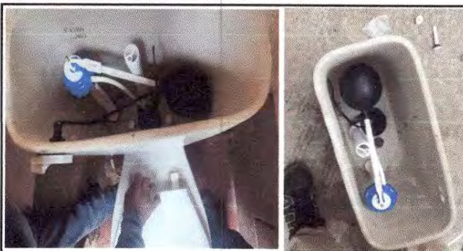
Foto 12: Sustitución de accesorios inodoro
