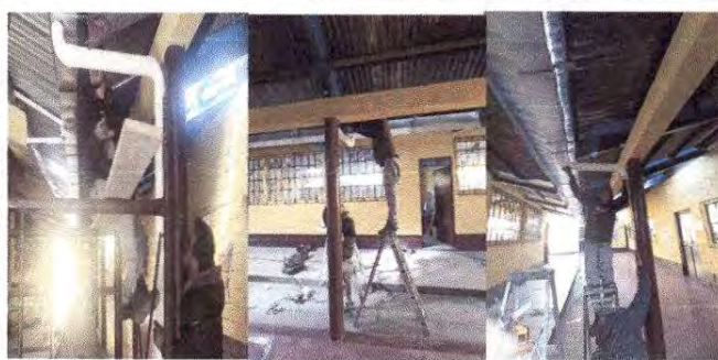
Foto 11: Sustitución y reparación de bajadas de agua pluvial con tubo PVC
