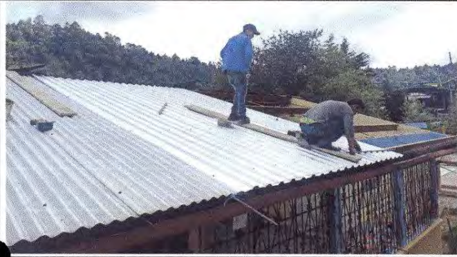
Foto 1: Sustitucion de lamina troquelada calibre 26 por lamina acanalada
