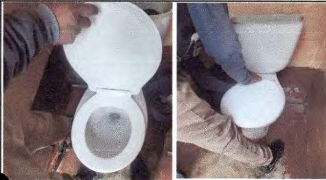
Foto13: Sustitucion de tapaderas sanitario
