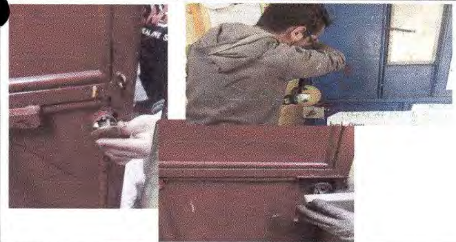
Foto 5: Sustitución de Chapas que estan descompuestas
