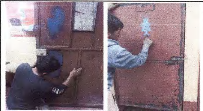
Foto 4: Mantenimiento de puertas de metal
